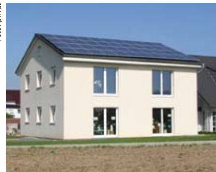
Das Plus-Energie-Haus im Gewand eines Selbstbaupassivhauses im Kreis Peine. Nahezu alle Arbeiten hat der Hausbesitzer selber ausgeführt.
