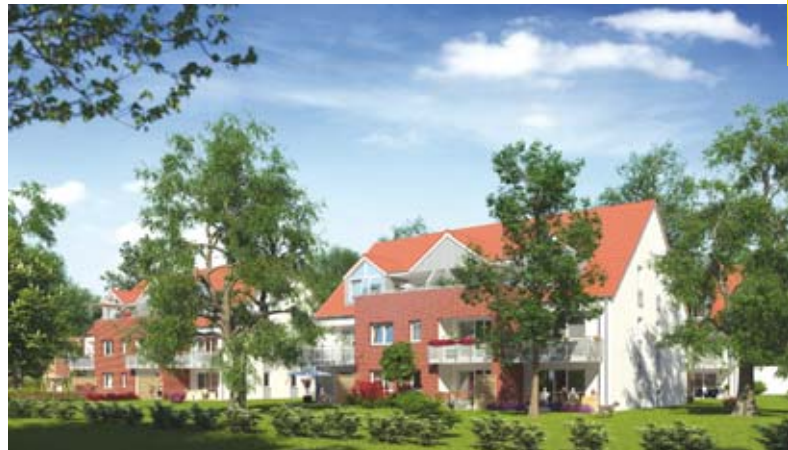
Im ehemaligen Gutspark von Pattensen sind 24 hochwertige Wohnungen mit Südausrichtung und einer hellen, freundlichen Atmosphäre entstanden.
