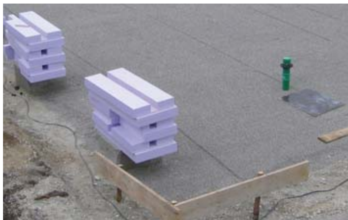
Das zum Patent angemeldete Stecksystem schließt Verlegefehler und damit Wärmebrücken komplett aus.
