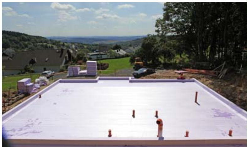
Ein Bauvorhaben beginnt nicht erst mit dem Betonieren der Bodenplatte, sondern bereits mit der darunterliegenden Dämmschicht.
