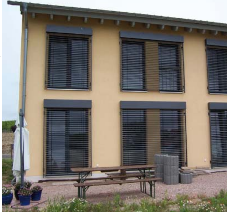
Hier ist das Grundprinzip eines Passivhauses – ein luftdicht geschlossener und gut gedämmter Kubus – verwirklicht.
