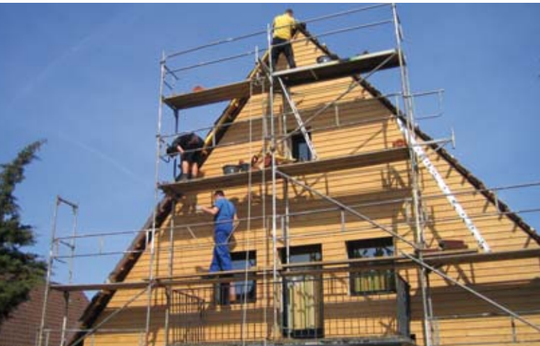
Die neue Fassade ist fast fertig: Hinter den Paneelen befindet sich jetzt eine starke Zellulose-Dämmung.
