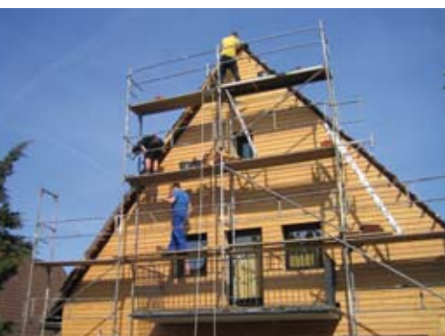
Altes Haus – neue Dämmung Seite 10
