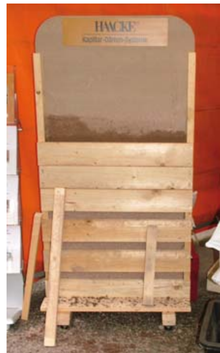
In der Verschalung wird Schicht für Schicht der Lehm eingestampft.
