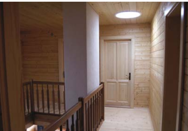
Über ein verspiegeltes Lichtrohr wird das Tageslicht ins Innere eines Gebäudes geleitet.
