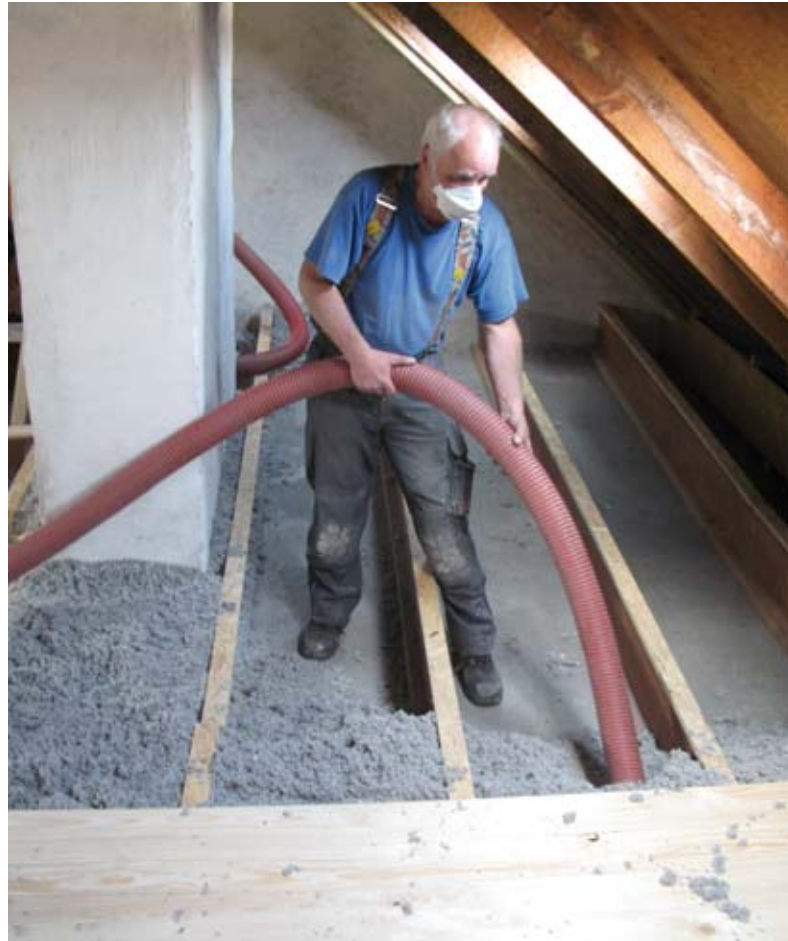
Isofloc- Fachbauleiter Rolf Wittmann füllt den Hohlraum unter den Dielen mit dem umweltfreundlichen Dämmstoff aus.
