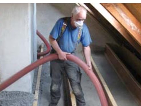
Dachboden gedämmt Seite 8
