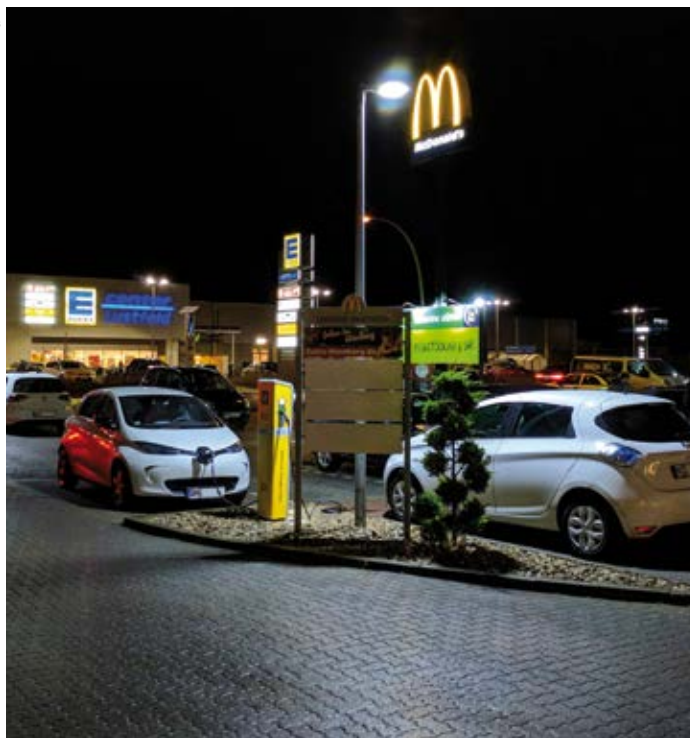
Bei McDonald's sind zusätzlich zu den Typ-2-Anschlüssen auch zwei Schuko-Anschlüsse vorhanden.
