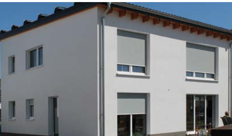
Saubere Luft dank ausgeklügelter Lüftungstechnik: Für die Bewohner gibt es eigentlich keinen Grund mehr, die Fenster zu öffnen.
