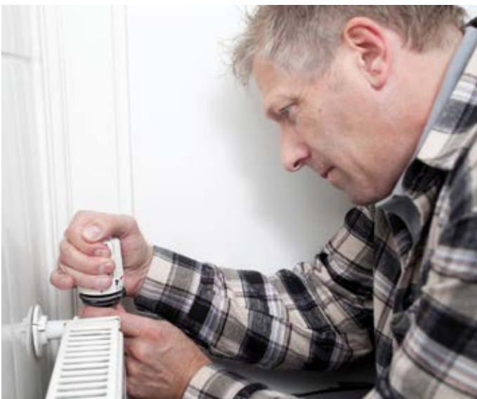
Auch die Überprüfung der Heizkörper gehört zu einer Heizungswartung dazu.
