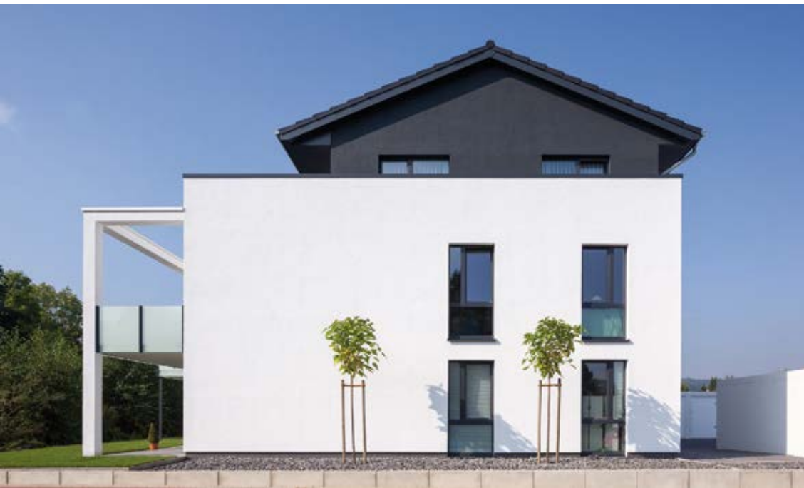
Bei der Konstruktion der Wände entschied sich der Architekt für massive Fertigteilwände aus zementgebundenem Blähton. Die Außenwände erhielten ein 15 Zentimeter starkes Wärmedämmverbundsystem.
