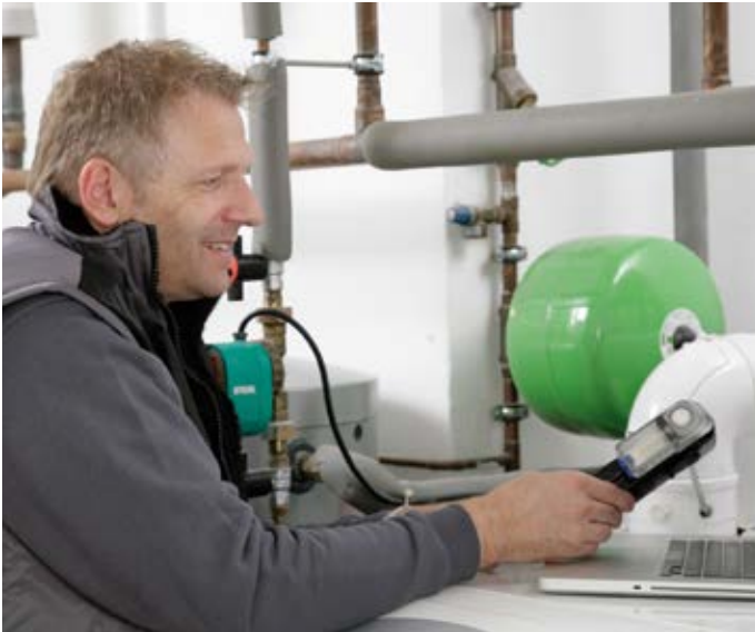
Bei der Heizungswartung werden sämtliche Einstellungen an der Heizung überprüft.
